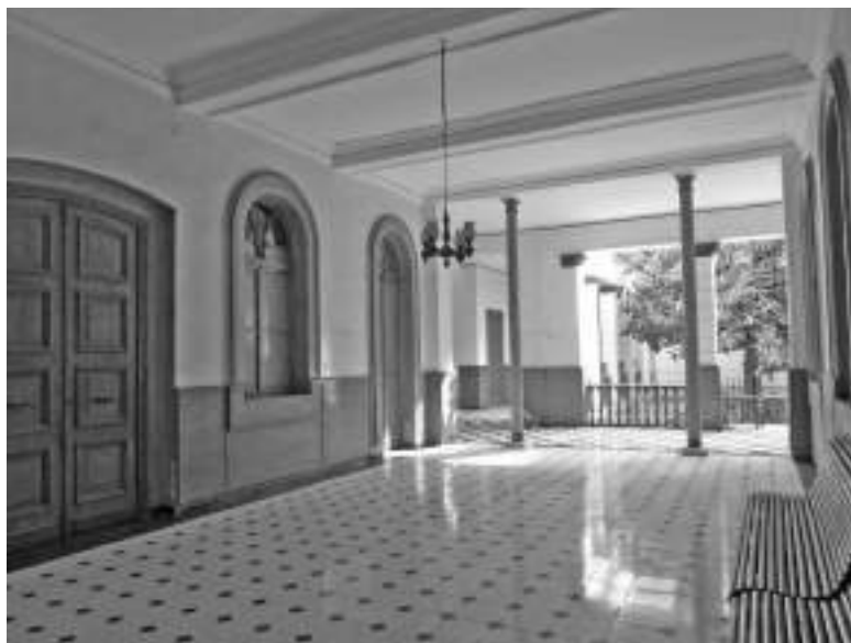
Εικ. 12. Κάιρο. Σιναϊτικό Μετόχι. Κεντρικό κτήριο. Άποψη του ημιυπαίθριου χώρου στα δυτικά του παρεκκλησίου με θέα προς το αίθριο.
