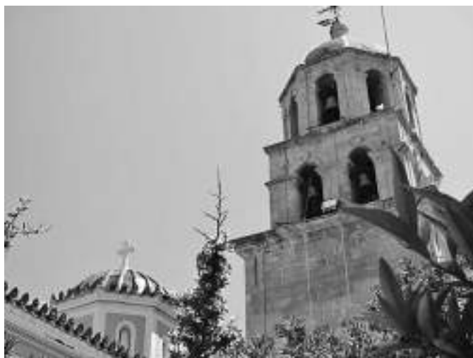
Εικ. 4 Χώρα Αίγινας. Μητροπολιτικός ναός. Κωδωνοστάσιο ( https://lh5.googleusercontent.com/p/AF1QipNCW4Fwt8qSfzJ77mKcwI6O9NrUaGcp-4VvVvD-=h1440 ).
