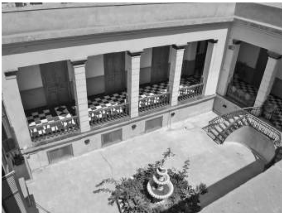
Εικ. 10. Κάϊρο. Σιναϊτικό Μετόχι. Το αίθριο στο μέσον του κεντρικού κτηρίου.
