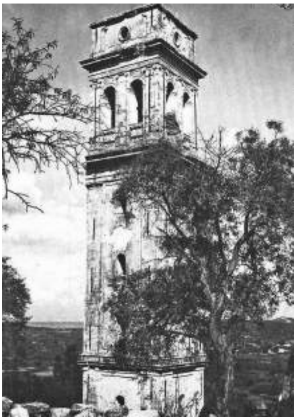
Εικ. 8. Σκουληκάδο. Ναός Υ/Θ Αναφωνήτριας. Κωδωνοστάσιο. Άποψη από τα νοτιοδυτικά [Βοκοτόπουλος, Κωδωνοστάσιον Σκουλικάδου (ό.π., υποσημ. 3), πιν. 423.α].
