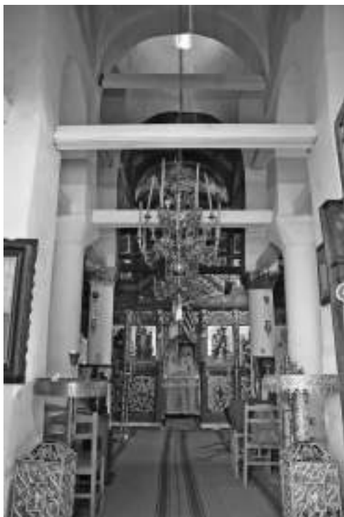
Εικ. 7. Μονή Αγίου Ιωάννου Θεολόγου Μελίβοιας. Καθολικό (1851). Εσωτερική άποψη. Το σύστημα των ελκυστήρων (Α. Πασαλή, 1 Φεβρουαρίου 2020)
