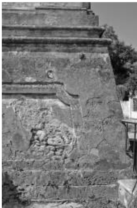
Εικ. 7. Σκουληκιάδο. Ναός Υ/Θ Αναφωνήτριας. Κωδωνοστάσιο. Μερική άποψη βάσης από τα βόρεια (Στ. Μαμαλούκος, Μάιος 2022).
