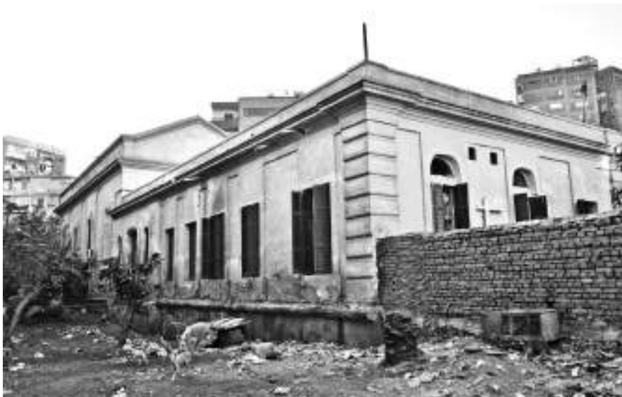
Εικ. 9. Κάϊρο. Σιναϊτικό Μετόχι. Άποψη από βορειοδυτικά του κεντρικού κτηρίου.
