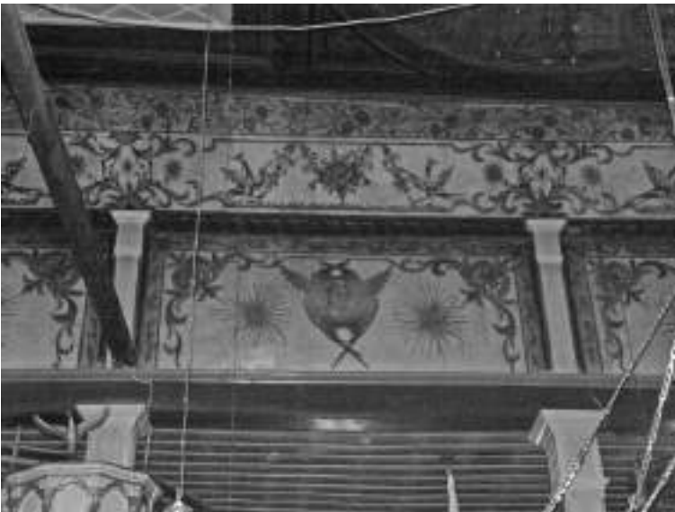
Εικ. 7. Λιβιάδι. Ναός Αγίου Αθανασίου (1843). Άνω τμήμα κιονοστοιχίας (Αρχείο ΕΦΑΠΕΘ, 2019).
