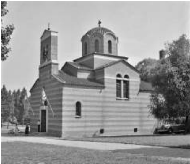
Εικ. 1. Ο ναός του Αγίου Νικολάου φωτογραφισμένος τον Ιούνιο του 1957 (Rotterdam City Archives, Ary Groeneveld).
